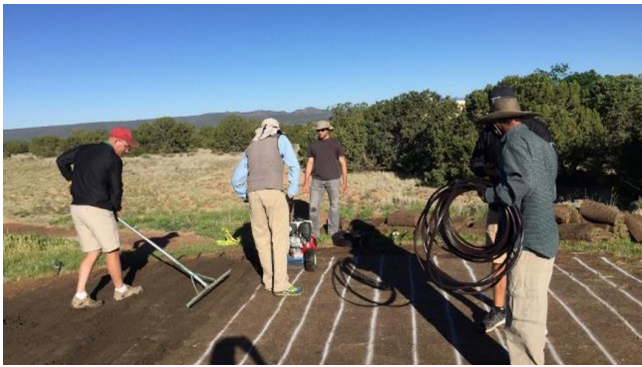
▲ A Las Campañas crew lays subsurface irrigation lines
